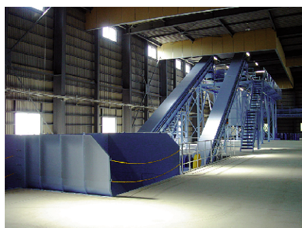
同工場 内観(機械設備)
