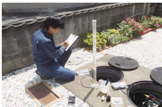
浄化槽法定検査
